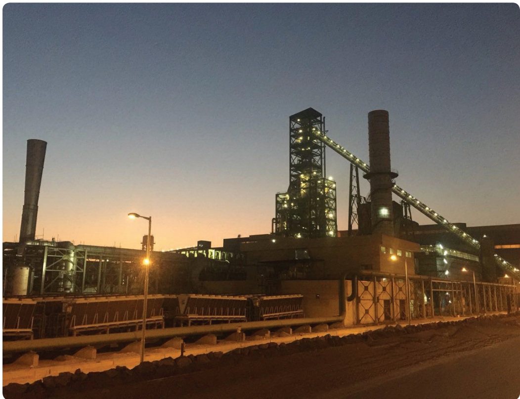
اجرای عملیات ساختمانی و نصب و راه اندازی واحد مگامول احیا مستقیم محل: اردکان، یزد
