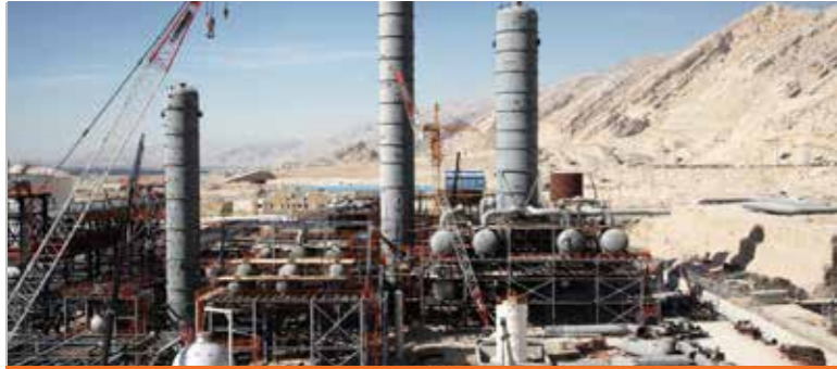
پروژه متانول سیلان (در دست اجرا)
