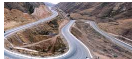
بازسازی و تعریض راه بیشکک - اوش
