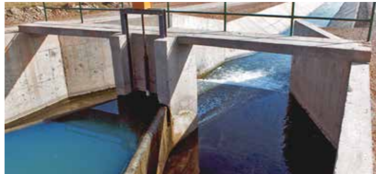
سد انحرافی و شبکه زهکشی و آبیاری پلدشت (تکمیل شده)
