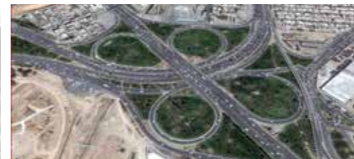
تقاطع غیر همسطح سه راه افسریه
