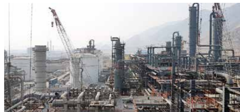
پروژه ابنیه صنعتی و نصب تجهیزات پتروشیمی دنا - عسلویه (در دست اجرا)
