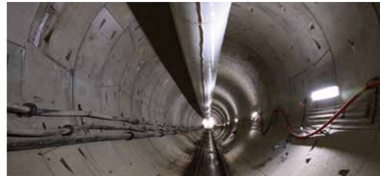
پروژه قطار شهری اهواز (در دست اجرا)
