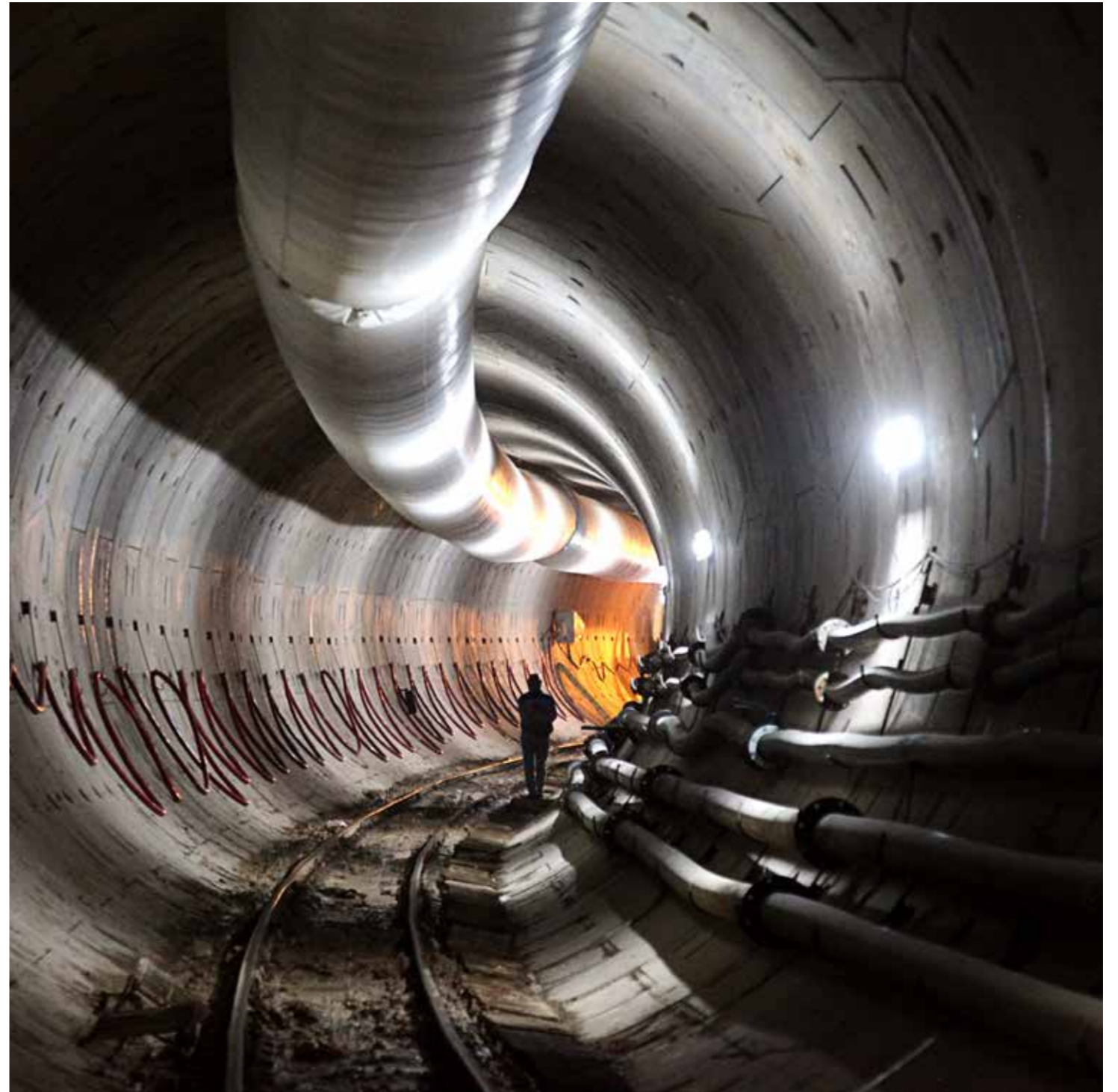
پروژه قطار شهری اهواز (در دست اجرا)
