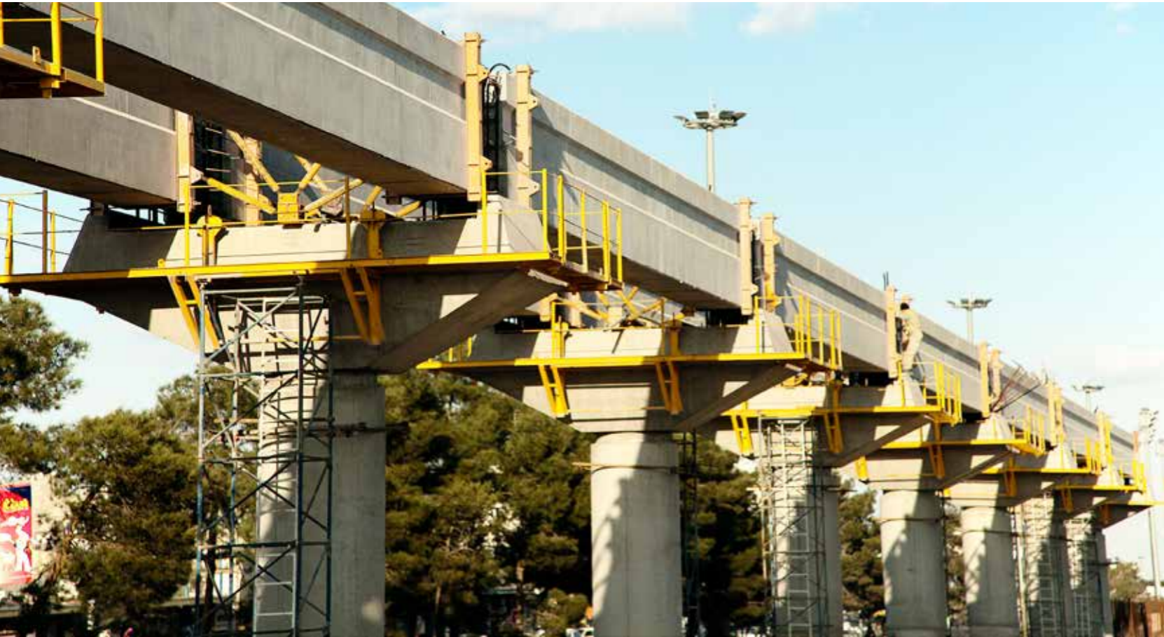
پروژه مونوریل قم (در دست اجرا)
