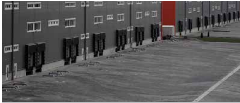
پروژه گندله سازی گل گهر (تکمیل شده)
